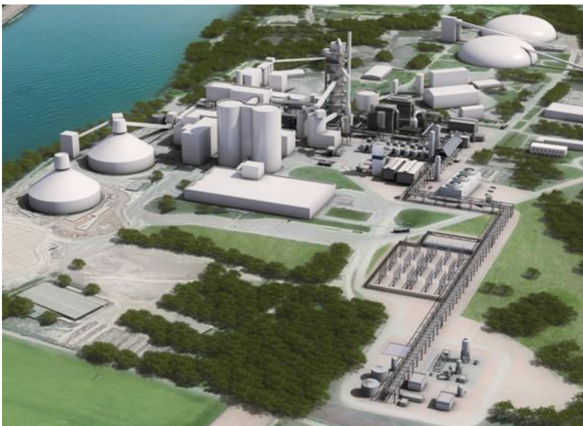
Vue réelle (en haut) et vue en 3D (en bas) de la cimenterie Vicat de Montalieu-Vercieu (source : Vicat) montrant l'emplacement de l'usine de captage du CO 2 (en noir).
